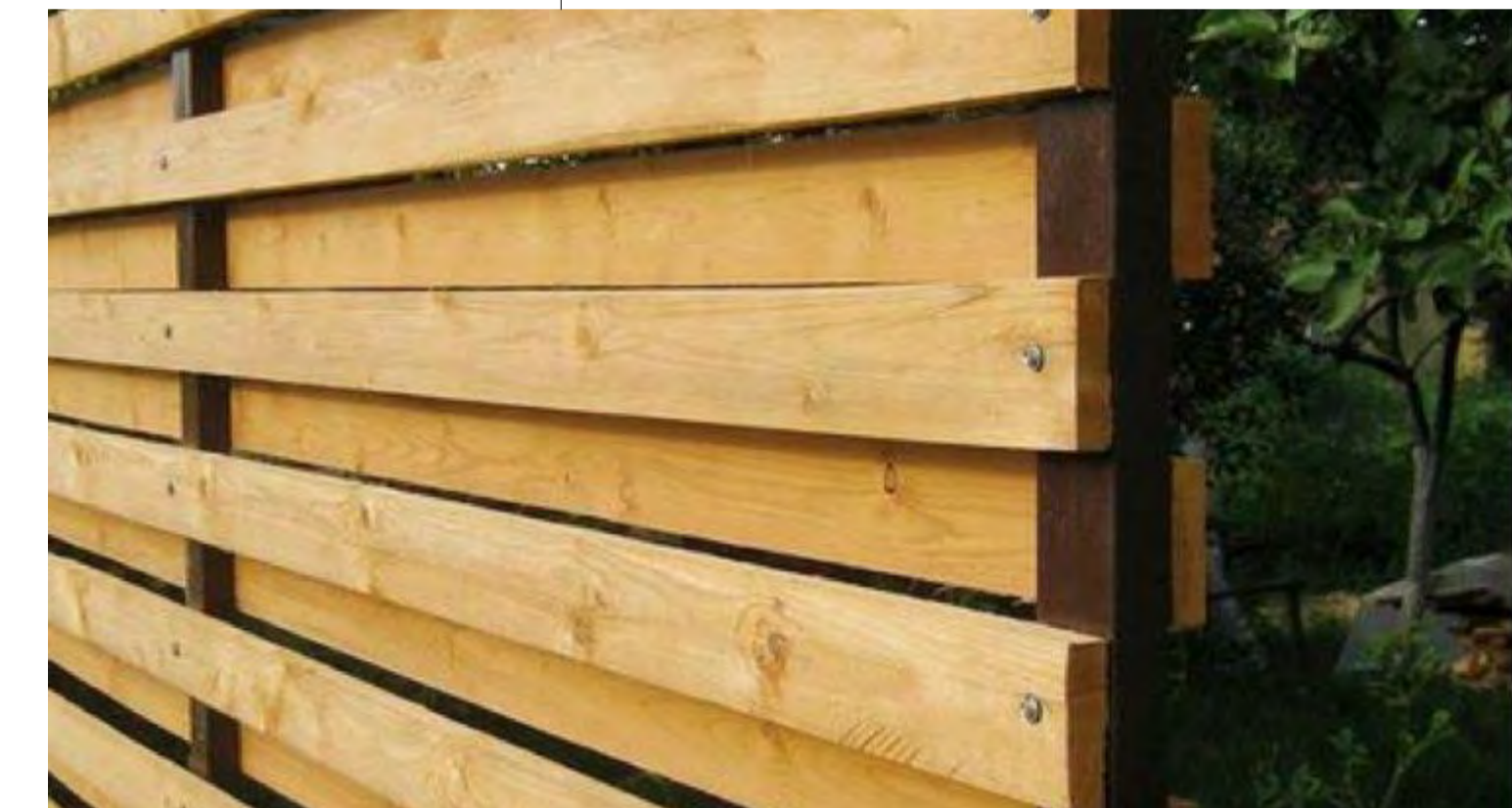
DOUBLE LAYER HORIZONTAL SLAT FENCING SCALE: N.T.S.
